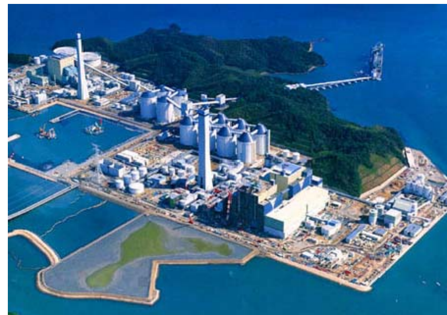
スリップフォーム (対角32m台形 自重400ton) 自律制御・連続上昇式煙突建設装置 電源開発・橘湾火力発電所 (1999年)
