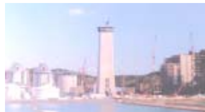
スリップフォーム (直径32m 自重420ton) 自律制御・連続上昇式煙突建設装置 東京電力・千葉火力発電所 (1997年)
